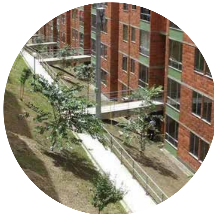
Acceso a la torre a través de puentes
